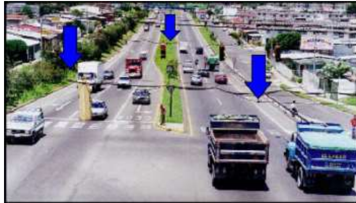
Vía rápida con isla separadora central y con islas laterales para separar la vía principal de las calles marginales. Fotografía 4.2
